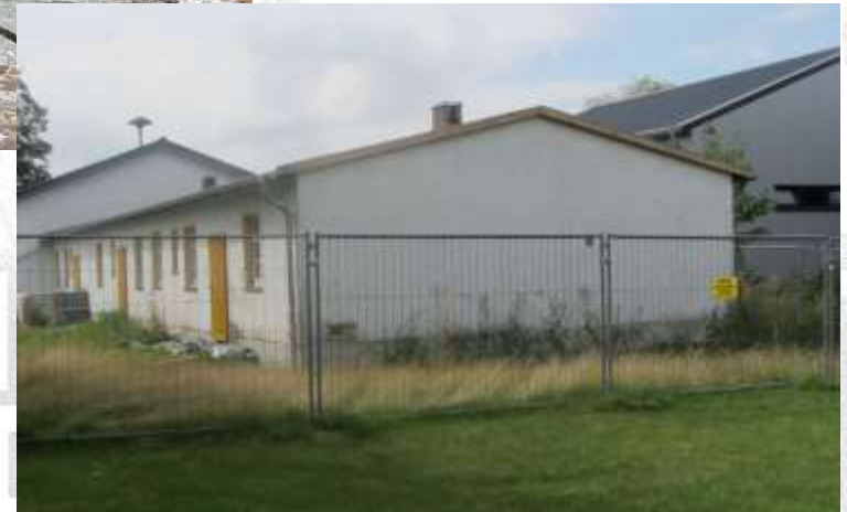
Noch erhaltenes Gebäude des KZs Niederhagen
