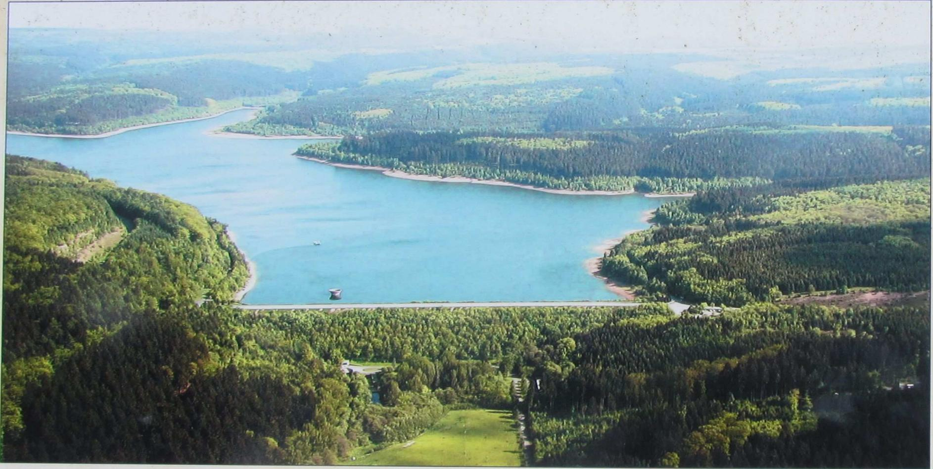
Der Gesamtstauraum der Talsperre umfasst 20,50 Mio m<sup>3</sup>. Hiervon entfallen 3 Mio m<sup>3</sup> auf den Hochwasserrückhalteraum und 17,5 Mio m<sup>3</sup> werden für Trinkwasser genutzt. Das Talsperren-Rohwasser wird in mehreren Stufen zu Trinkwasser aufbereitet. Hiermit werden über Fernleitungssysteme mehr als 200.000 Einwohner der Kreise Paderborn, Soest, Gütersloh und Warendorf versorgt.
